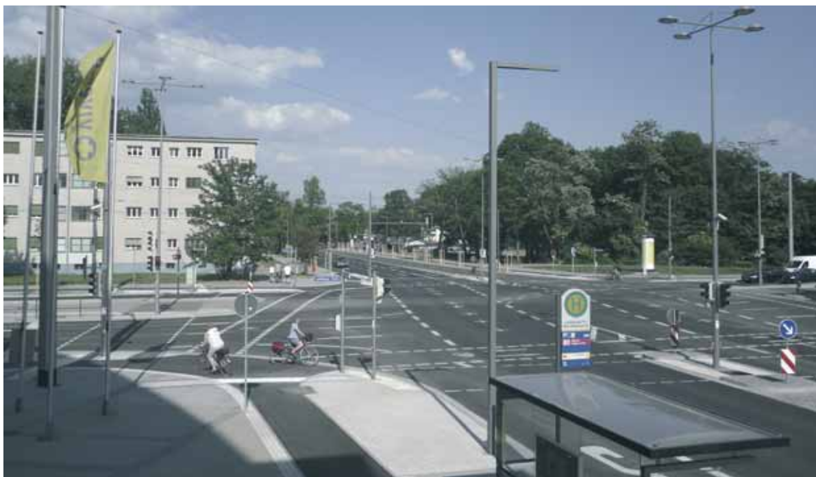
Der neu gestaltete Kreuzungsbereich zwischen Landsberger Straße und Max-Liebermann-Straße (Mittlerer Ring)
