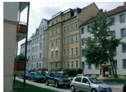
Sanierte Wohngebäude in der Cranachstraße
